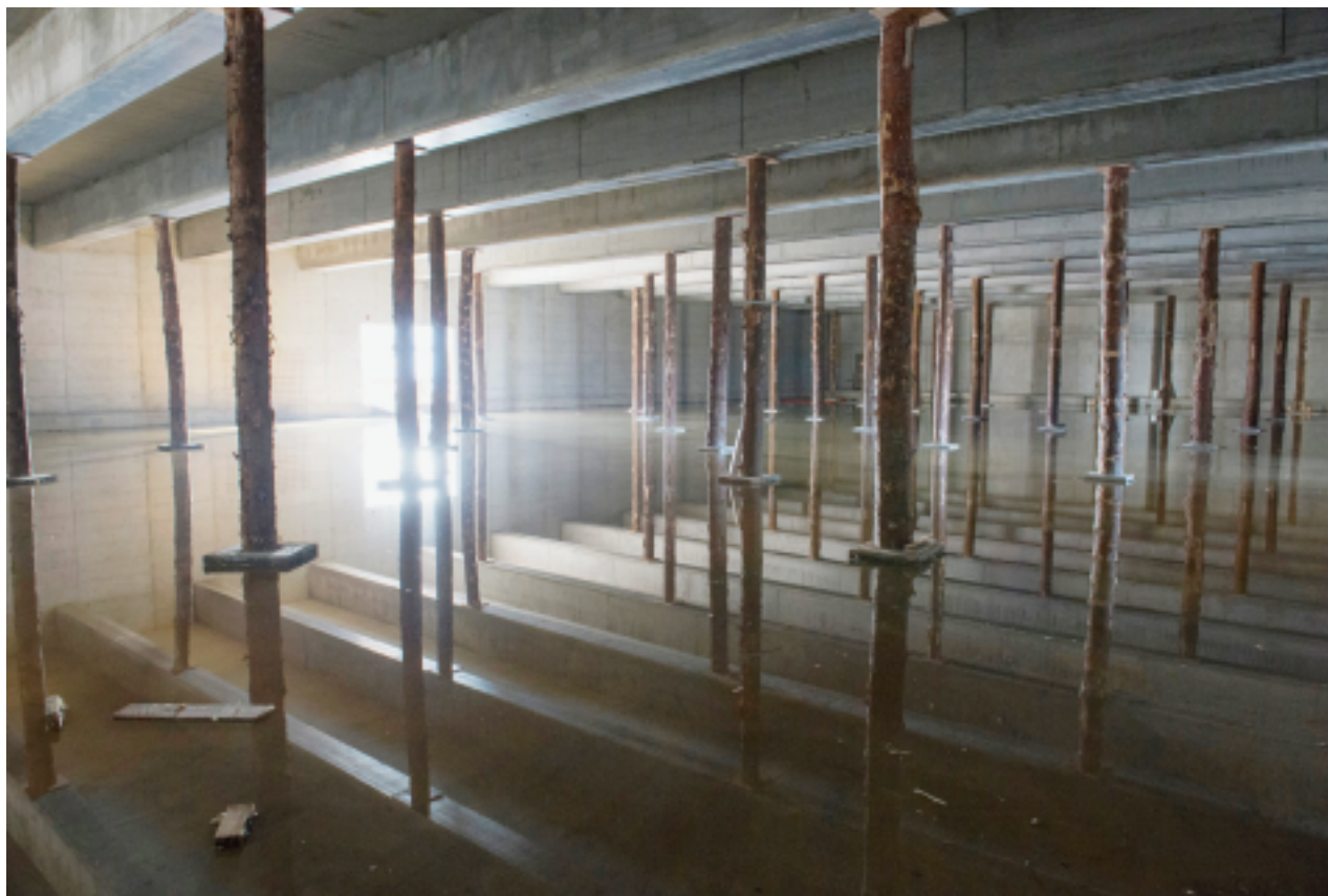
Auf der Baustelle: Hier werden sechs Rinks erstellt. Sowohl die regionalen Curler als auch der nationale Curlingverband Swiss Curling werden die neue Halle nutzen.
